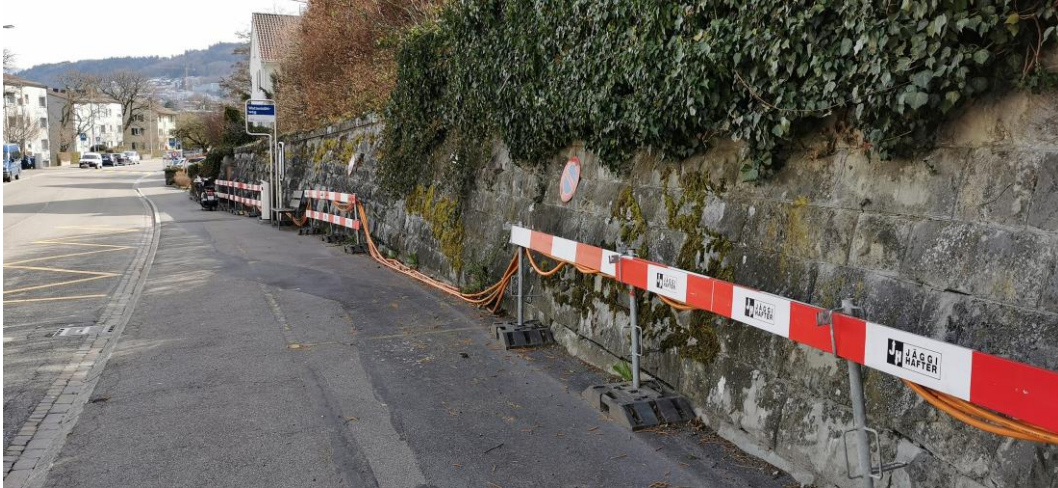
Abbildung 2: Stützmauer aus Naturstein (Foto AFRY, 25.03.2021).
