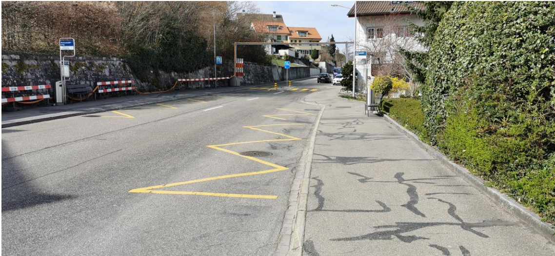
Abbildung 16: Bushaltestelle Wattenbühlweg, Oberrieden - Blickrichtung Thalwil, Ostseite (AFRY, 25.03.2021).
