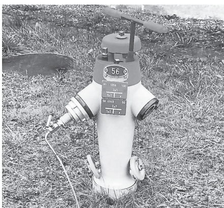
Wasserproben ab Hydrant.
